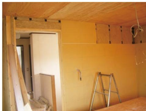
石膏ボードを2重貼りしてください。必ず下貼りの石膏ボードとジョイント位置をずらし固定してください。
