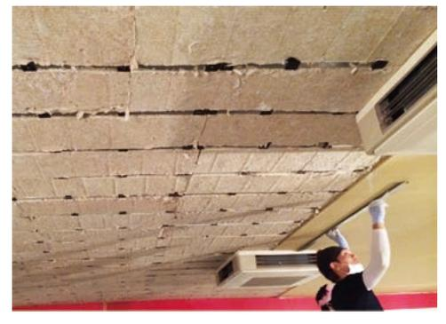
石膏ボードを2重貼りしてください。必ず下貼りの石膏ボードとジョイント位置をずらし固定してください。
