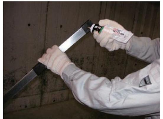
下地がコンクリートの場合、音パットゴム部・軽量材の裏側に接着剤を塗り固定してください。
