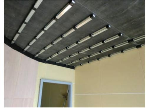
天井：音パット303mmピッチで施工
