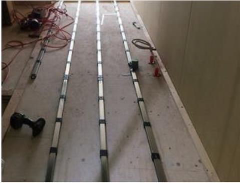
床：音パット303mmピッチで施工
