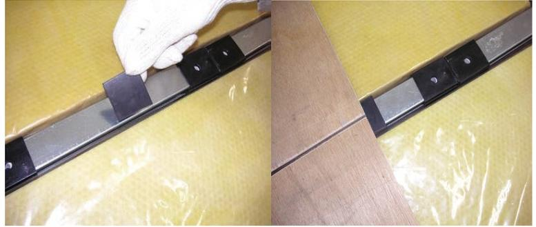
合板・石膏ボードは、基本的にゴム部にビス止めしますが、ジョイント部がスチール部になる場合、付属のゴムパッキンをカットし写真のように貼付け施工してください。
