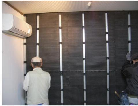
壁：音パット455mmピッチで施工
