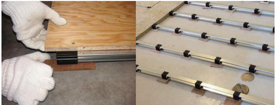
下地のレベル調整は、音パットの下にカットベニアなどを敷き込み調整してください。
